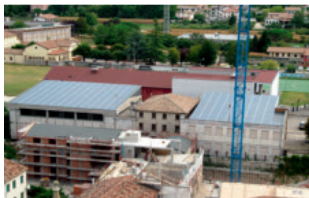
I due tetti fotovoltaici visti dal campanile
