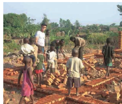
Villaggio Careni lavori in corso
